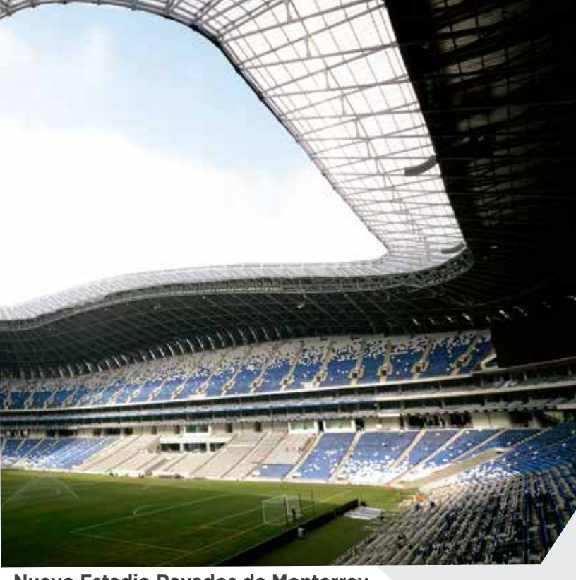
Nuevo Estadio Rayados de Monterrey Cubierta Danpalon 16mm
