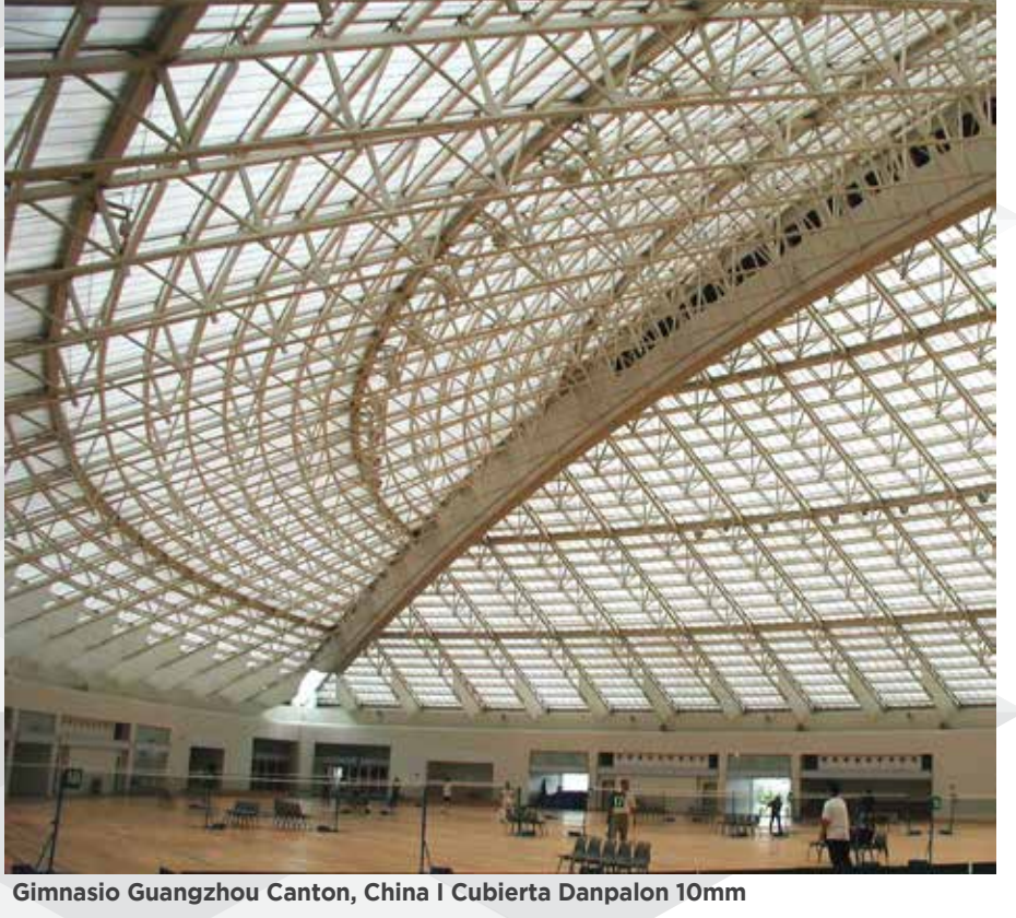
Gimnasio Guangzhou Canton, China | Cubierta Danpalon 10mm
